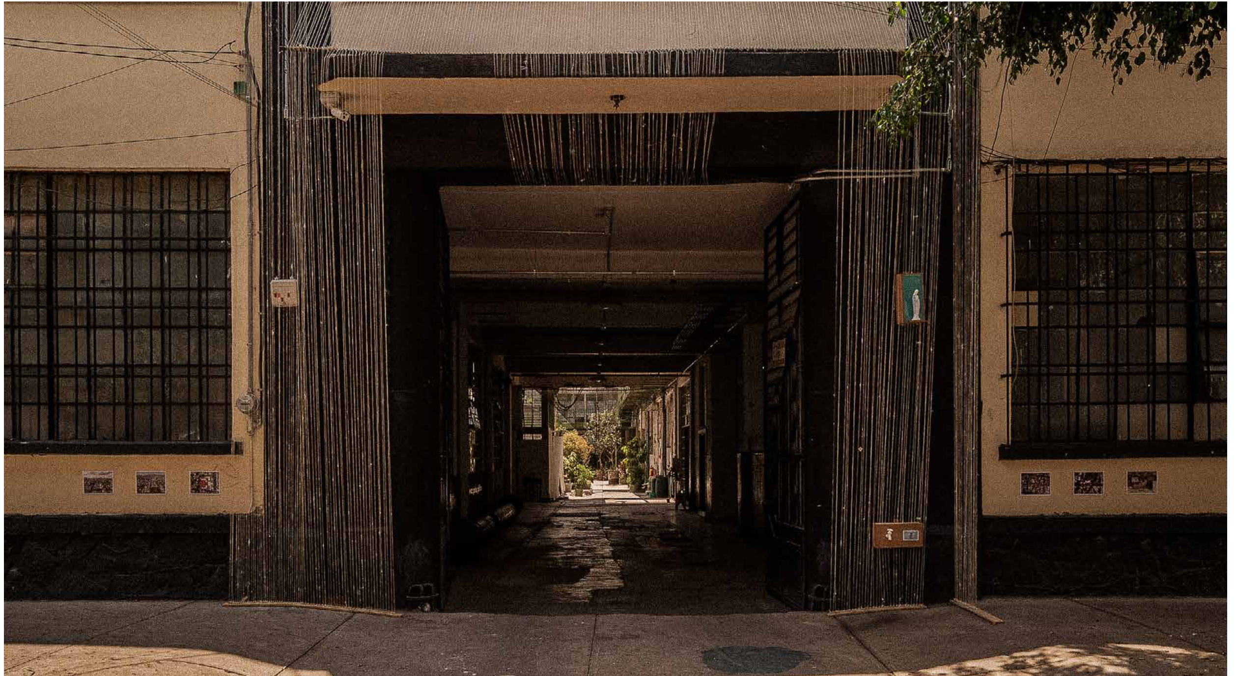
Punto de acceso Dr. Lucio a puerta abierta, activadores y patio central de Laguna al fondo, vista desde calle. Fotografía: Andrés Cedillo.
