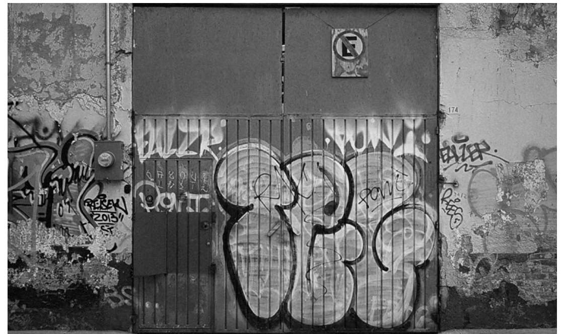
Punto de acceso en galerón industrial con nulo proceso de intervención y baja producción de actividades al exterior. Fotografía: Diego González Albarrán.
