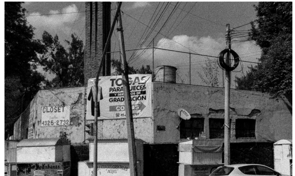
Z06 Locales comerciales y carteles informativos de servicios desde fachada T4 sobre Dr. Río de la Loza. Fotografía: Diego González Albarrán.
